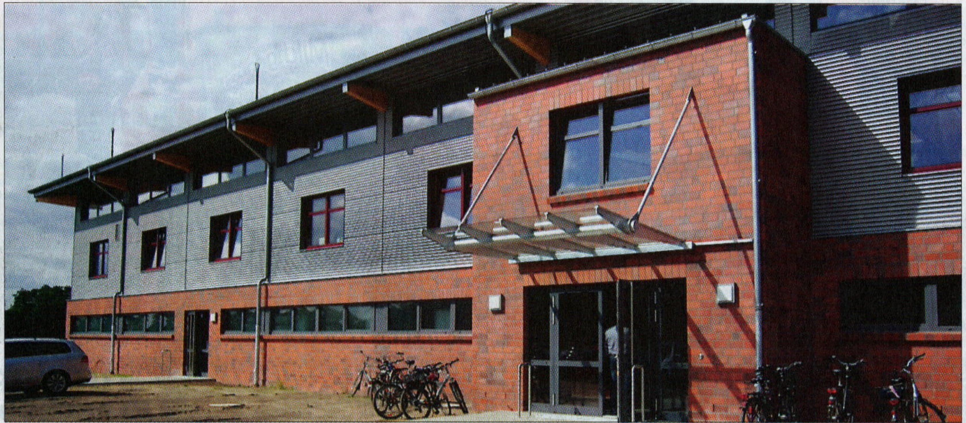
Kurz vor Beginn der Sommerferien ist jetzt die neue Sporthalle in Brietlingen fertiggestellt und feierlich eröffnet worden.
